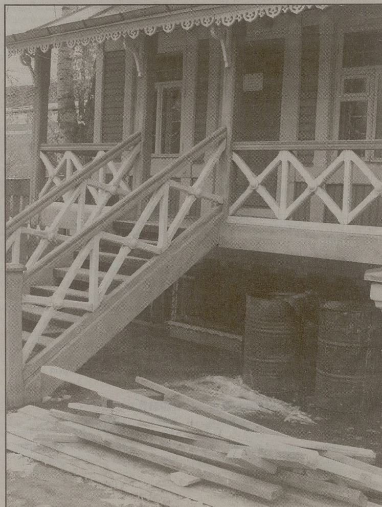
Идет ремонт Российско-немецкого дома
