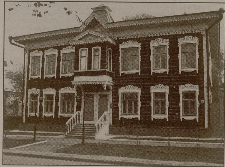
Отреставрированный дом по ул. Дзержинского, 16
